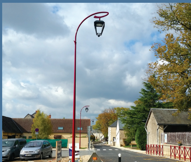
ETRECHY : Fin de chantier d'enfouissement des réseaux.
