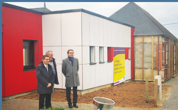
RIANS : Visite de l'école maternelle après les travaux d'isolation.
