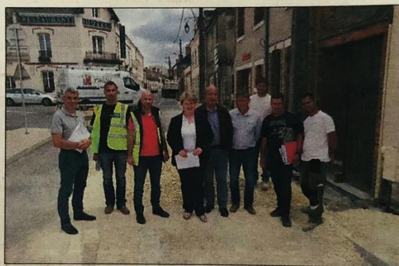
Élus et entreprises ont présenté les travaux effectués rue du Château.
